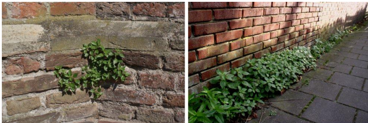
(L) Klein glaskruid op een kerkmuur in Asperen op 13 juli 2008 en Klein glaskruid tegen een muur in een brandgang in Zevenaar op 30 oktober 2006 (R)
