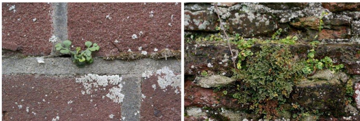
(L) Muurvaren op een nieuwe muur bij Slot Loevestein op 12 juni 2008 en op een eeuwenoude muur in Buren op 27 november 2008 (R)
